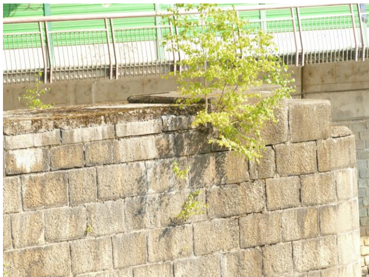
Pilíř P 01: dřík – vypadané spárování, nárůst vegetace
