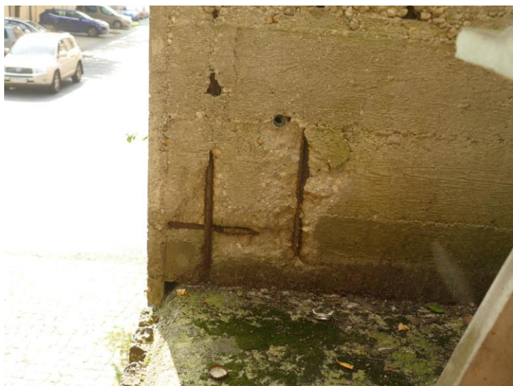
Opěra O 01: závěrná zed' – obnažená výztuž s korozí na pravé boční stěně
