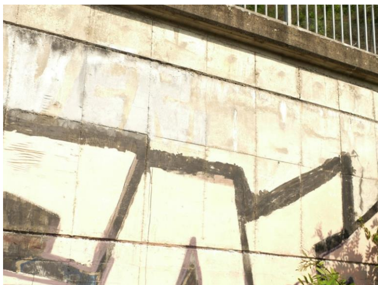
Opěra O 02: křídlo vpravo – průsaky vody s výluhy pojiva z pracovní spáry
